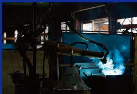
溶接作業②
